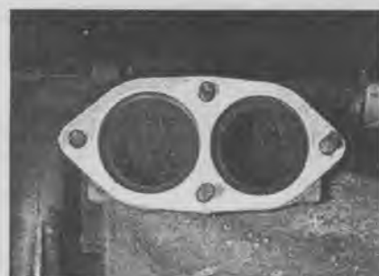
16.8 Новая прокладка на фланце приемной трубы выхлопной системы
