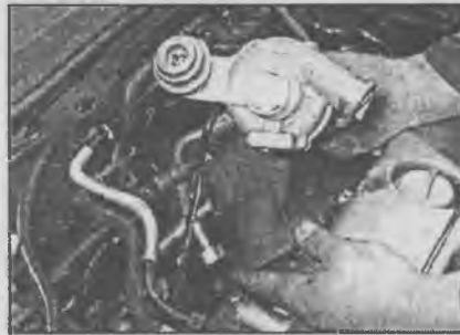
4.41. Снятие выпускного коллектора с двигателя
